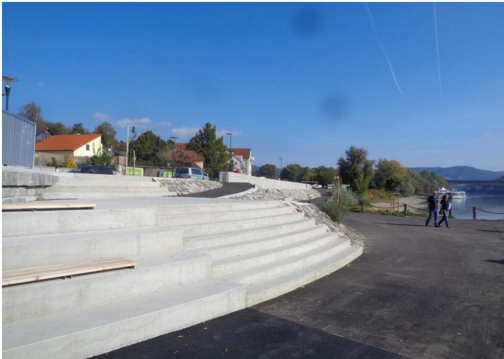
Neugestaltung Donauparkplatz (Schiffanlegestelle)
